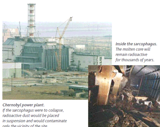
図 2.1-13 チェルノブイリ発電所4号炉石棺の外観とその内部—Source: IRSN(2006) ‘Chernobyl’—
