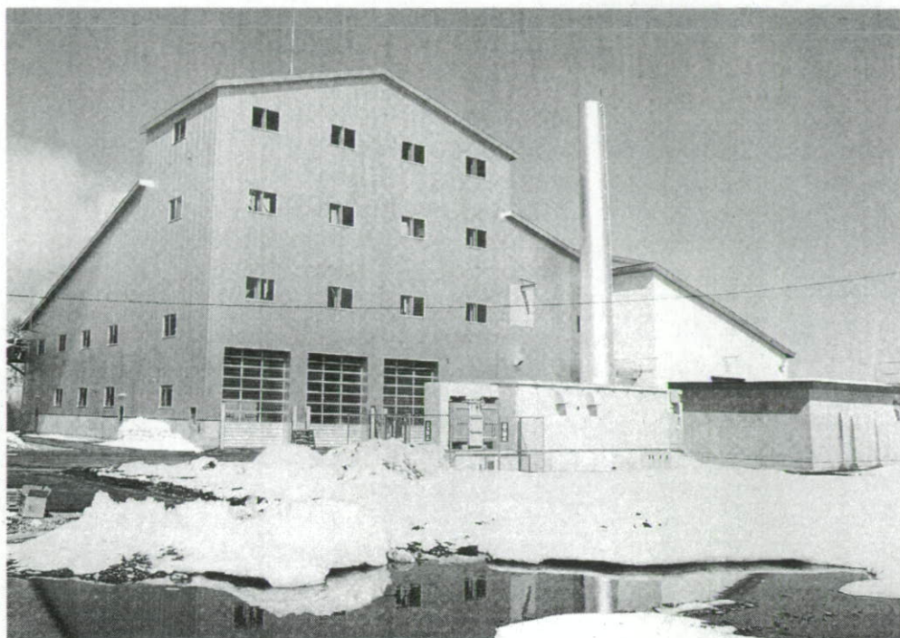
十勝化成工場（北側より）
