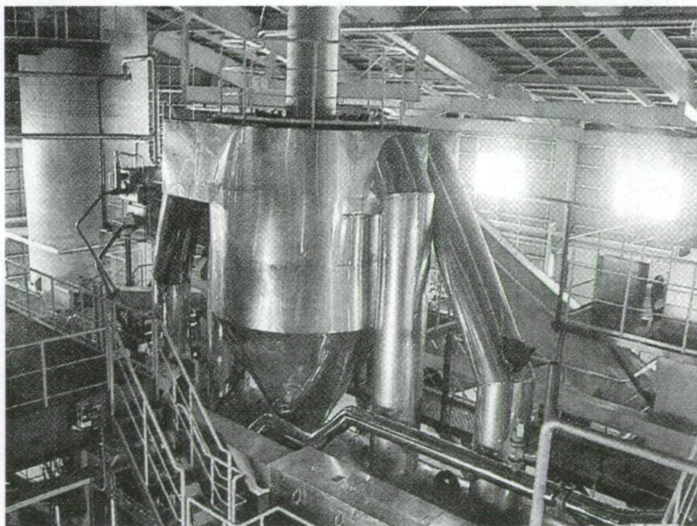
化成工場機械室
