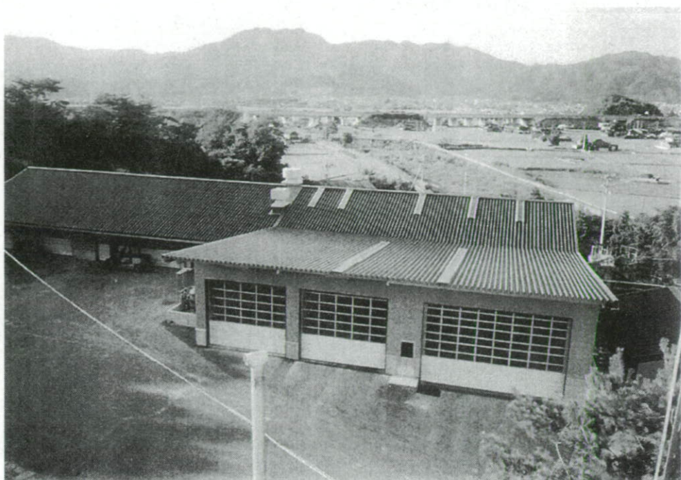
外部景観（南側）
