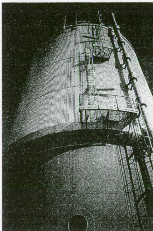
図 2.1.3 発酵槽 in プレヒト
