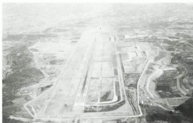
熊本空港の周辺には 広大な緑の開発可能地が残っている。
